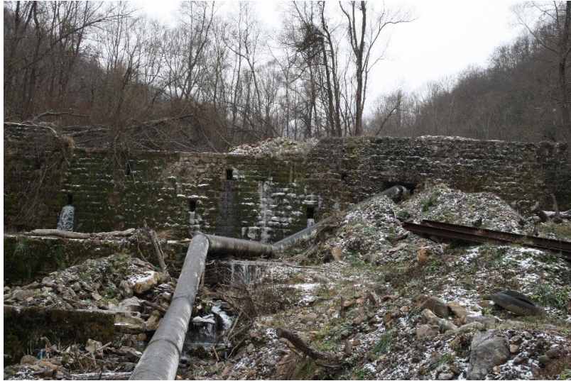
Слика 15. Уништен зуб слапишта на депонијско-консолидационој прегради број 2 на потоку Ракита (МХЕ „Звонце“) (Фото: Ратко Ристић)
