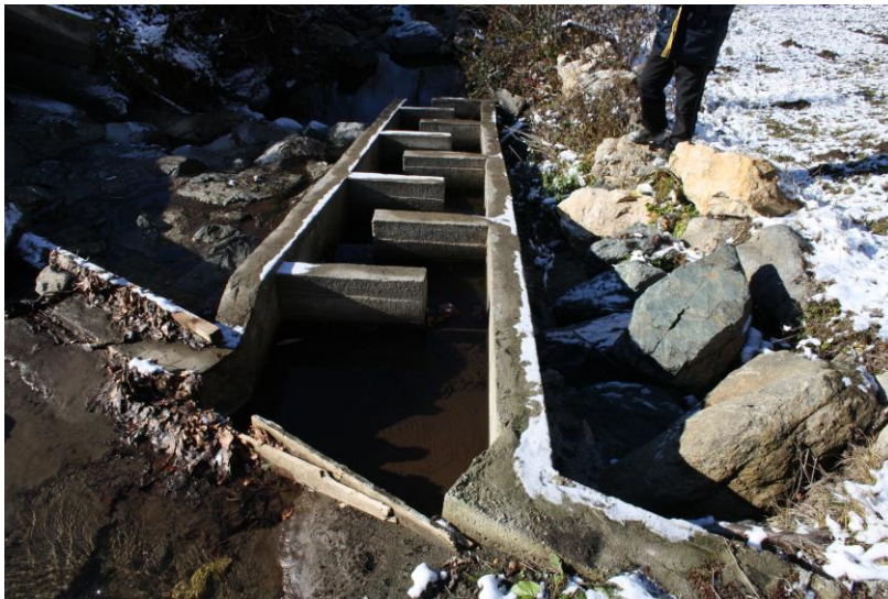
Слика 10. Затворен улазни профил рибље стазе (МХЕ „Клупци“) (Фото: Ратко Ристић)
