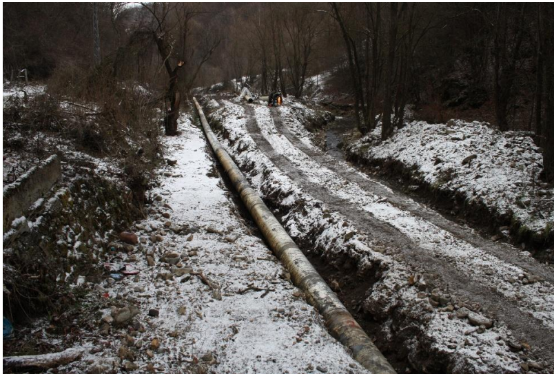
Слика 6. Полагање деривационог цевовода у кориту за велику воду (МХЕ „Звонце“)
