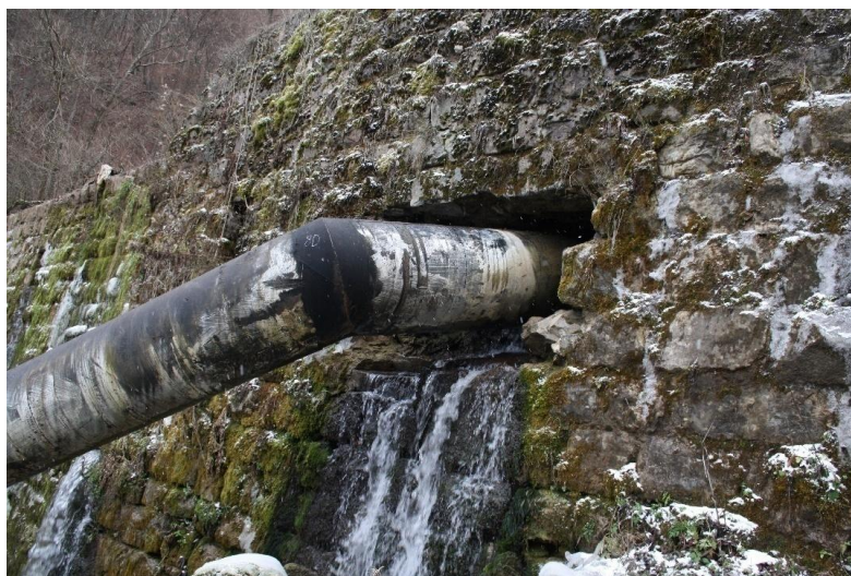
Слика 14. Пробијена депонијско-консолидациона преграда број 2 на потоку Ракита (МХЕ „Звонце“) (Фото: Ратко Ристић)
