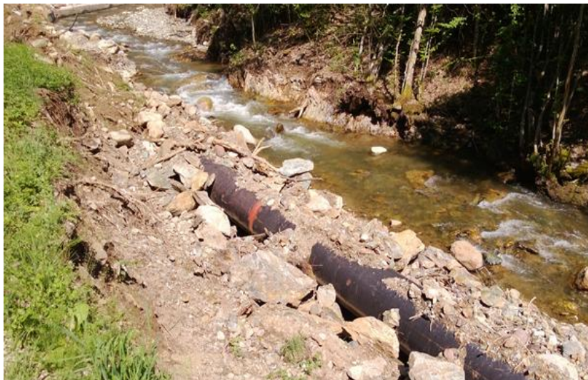
Слика 7. Полагање деривационог цевовода у кориту за велику воду (МХЕ „Мездреја“)
